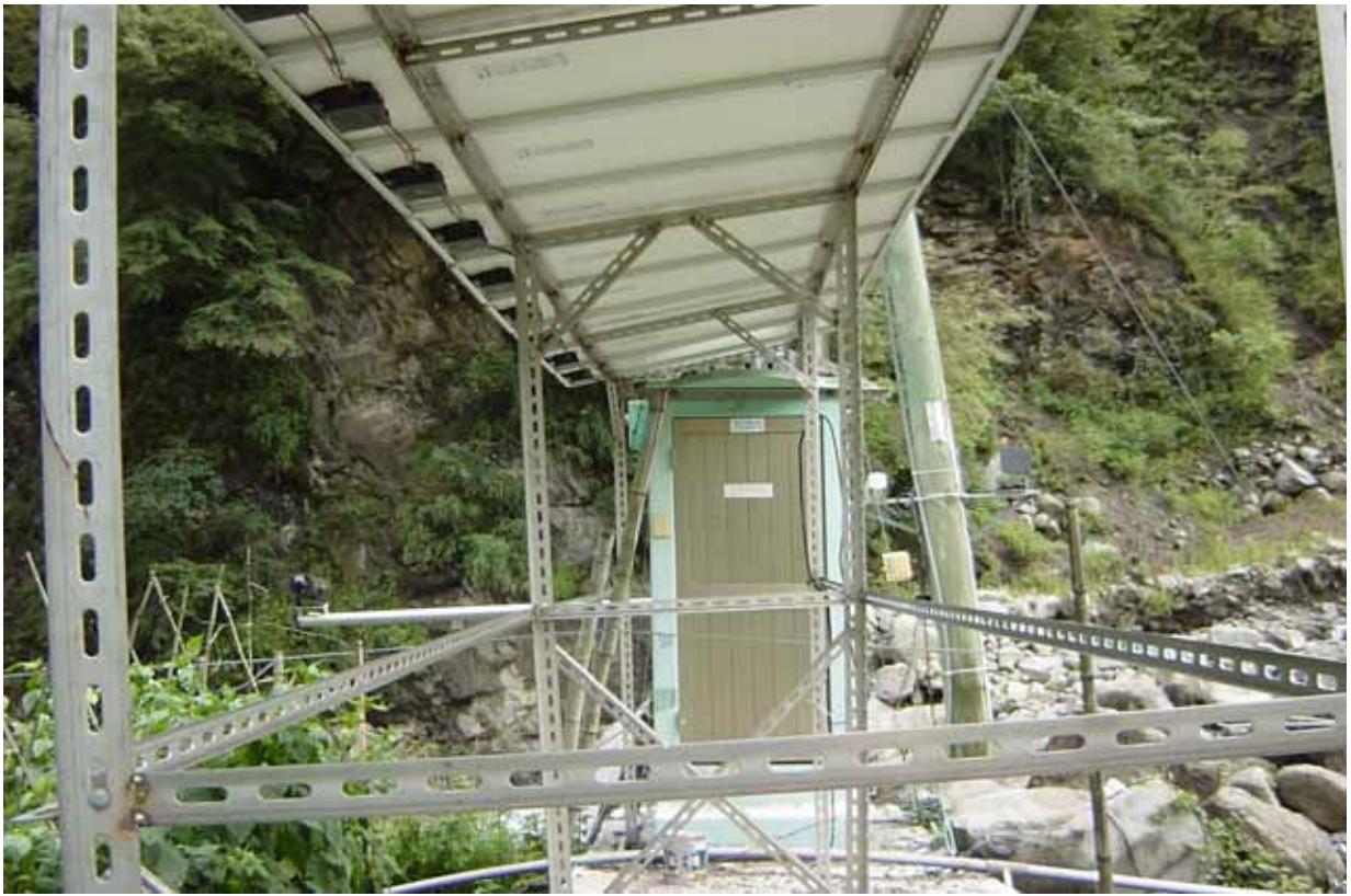
圖 2.5 照片顯示太陽能面板裝置方式，十片面板形成一個長廊形。
