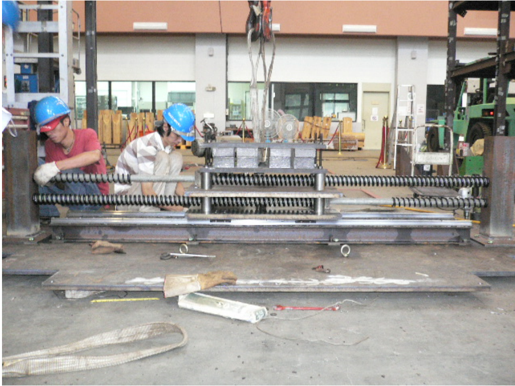
照片 3.3 PTMD 裝設於頂板
