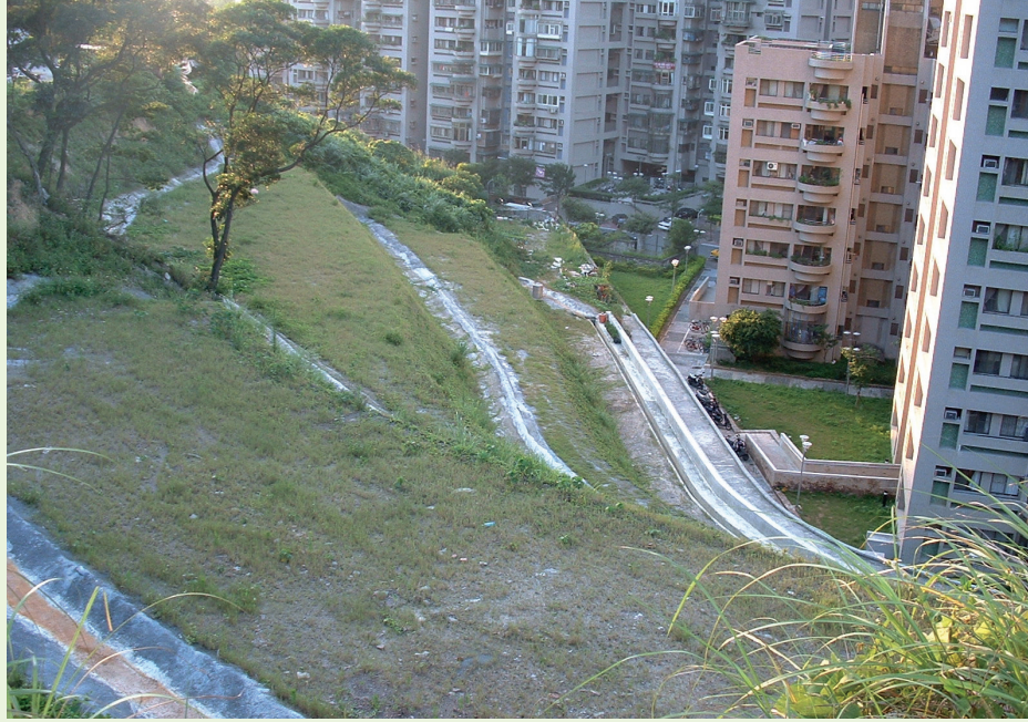
● 臺北市南港國宅後方之礦渣堆過去曾發生土石流情事，現已植被及護坡處理。
