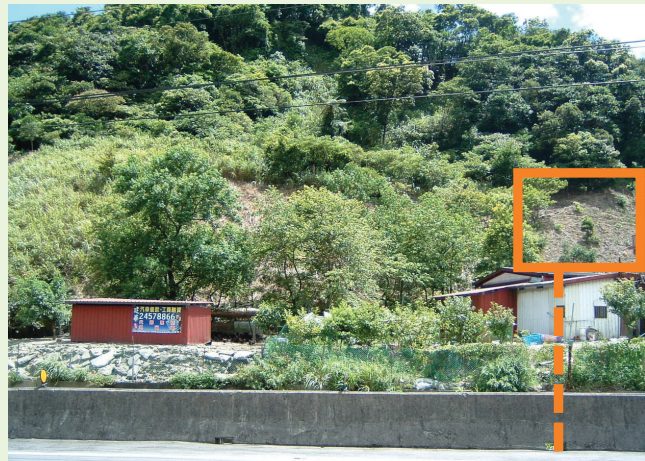
●雙溪鄉新拓煤礦礦渣堆上方之民宅。
