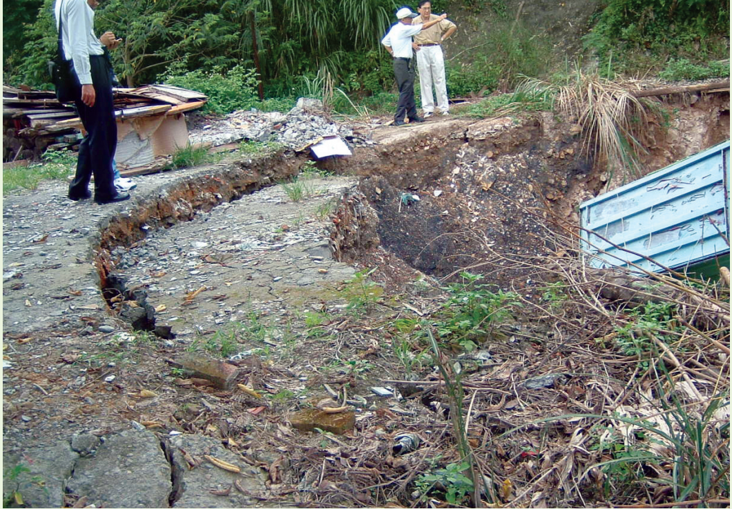
● 中和市東運瓷土礦（舊彰和煤礦）第二下陷區位於舊坑道及礦渣堆上方，其下陷深度達5公尺以上。
