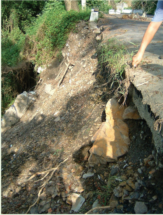
● 新店市直潭附近產業道路建於金城煤礦礦渣堆上方，已有路基毀壞之虞。
