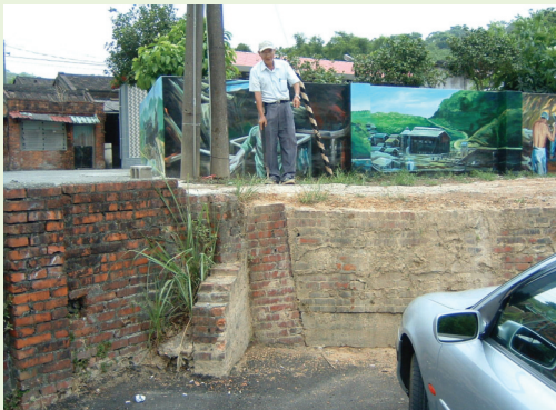
●八堵煤礦坑口現以水泥灌漿封閉，紅磚拱門之坑口位置仍可見。
