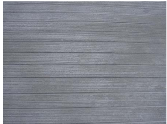
圖 11 36 跑道端剛性鋪面鋸槽深度不足現象 (僅約 2~3mm)
