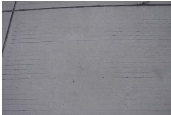
圖 12 36 跑道端剛性鋪面鋸槽不均勻現象
