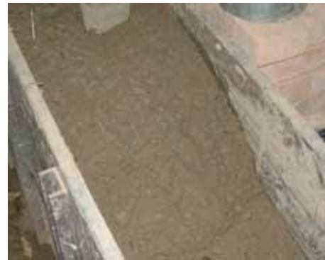
圖 4.12 第二組坡度 60° 土體崩塌情形
