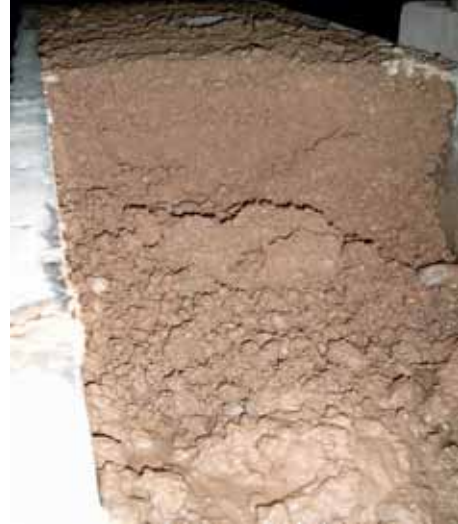
圖 4.8 第二組坡度 90° 土體崩塌情形
