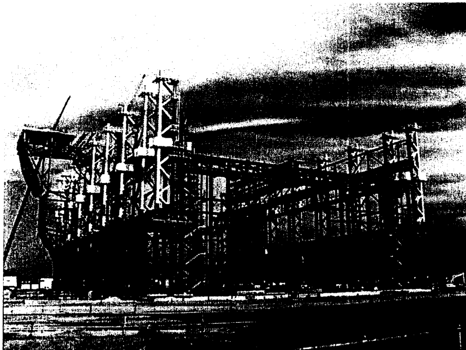
照片四十二 防災科學技術研究所實體三次元震動破壞實驗設施 2001.11.15 施工狀況
