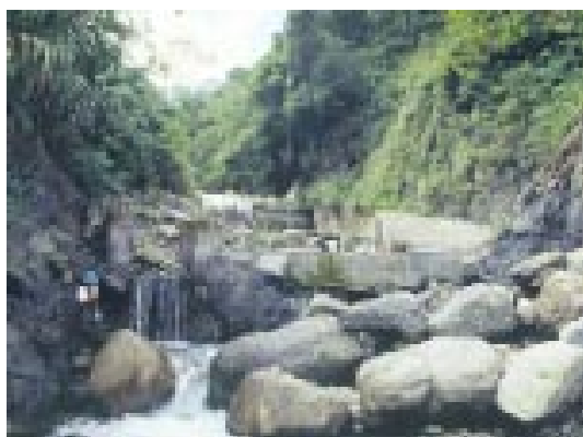
上、中圖：魚道出口堵塞為常見失敗案例（乾、雨季）。（張世倉 攝）
