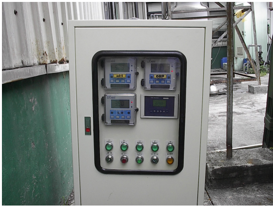
圖 7. 完工後之小型活性污泥/生物接觸曝氣法合併系統之監控系統外貌
