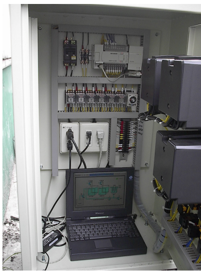
圖 8. 監控系統之內部情況包括一台筆記型電腦及各種電子式監控裝置
