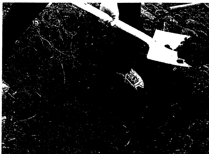
圖 3-10 挖深工作進行中
