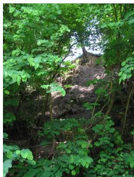
照片十九 花園新城現地調查問題-路口處上方有些許落石崩塌
