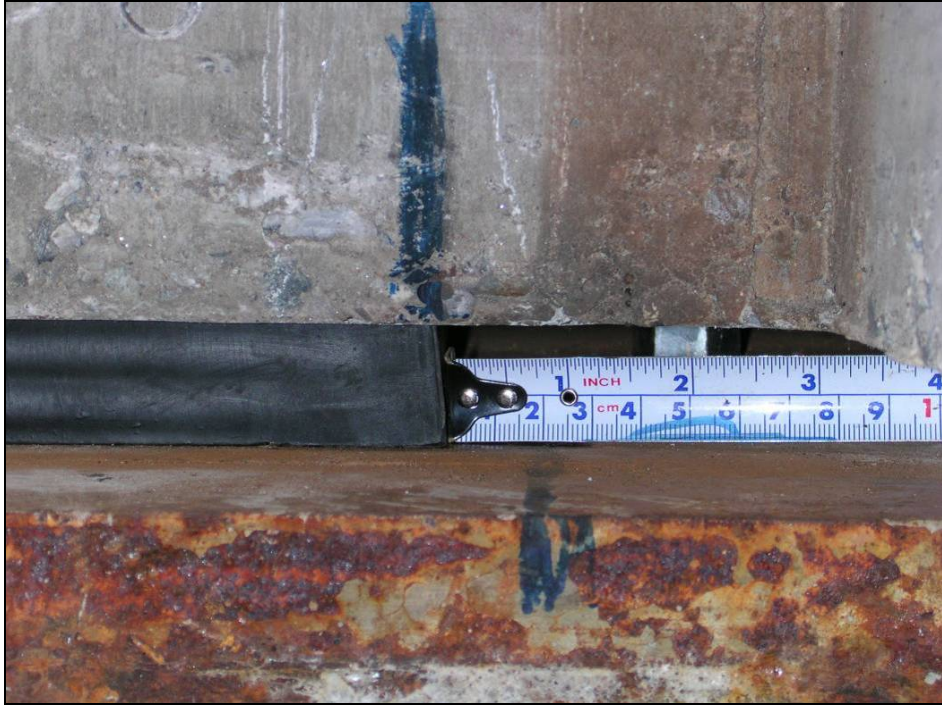
照片 3.9 支承墊的位移量被止震鋼棒所限制
