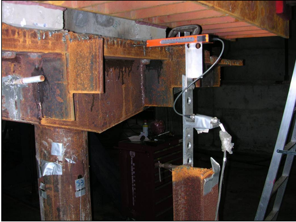
照片 3.3 橋柱頂端位移計的架設
