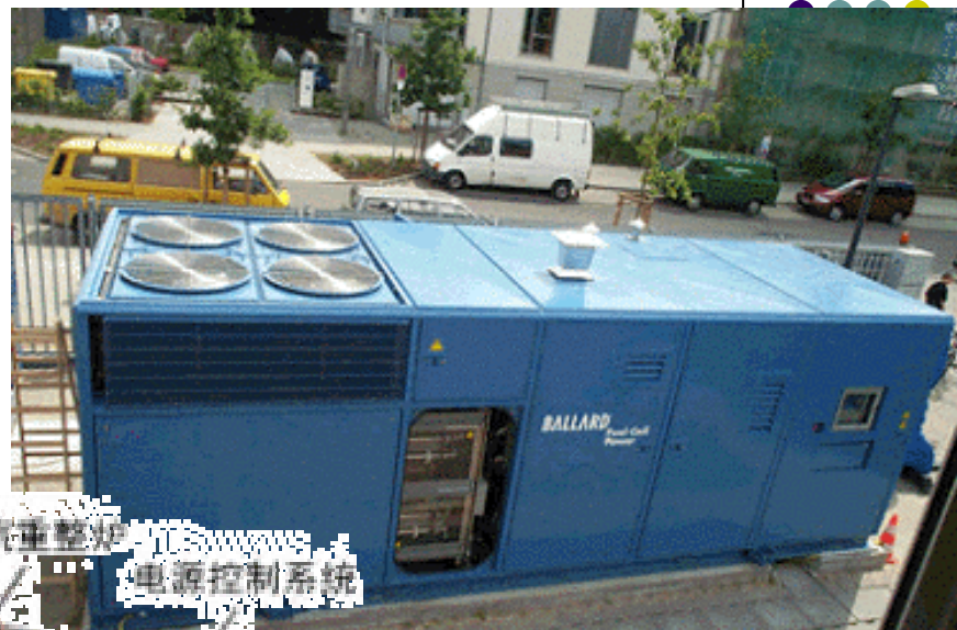
安裝在柏林的250kW PEMFC燃料電池電站
