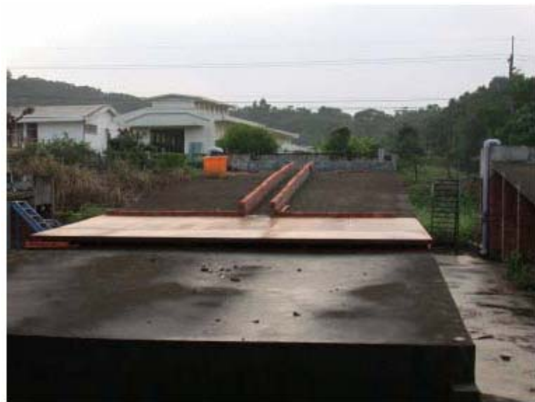
圖5-3-3 實驗渠道現場照片（已建造渠道）
