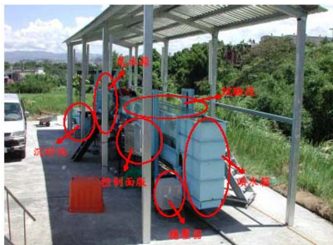
圖 5-2-2 試驗渠槽之實際照片
