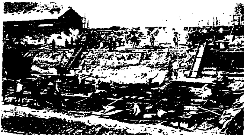
民國十年花蓮糖廠光復工場建設興工基礎工程
