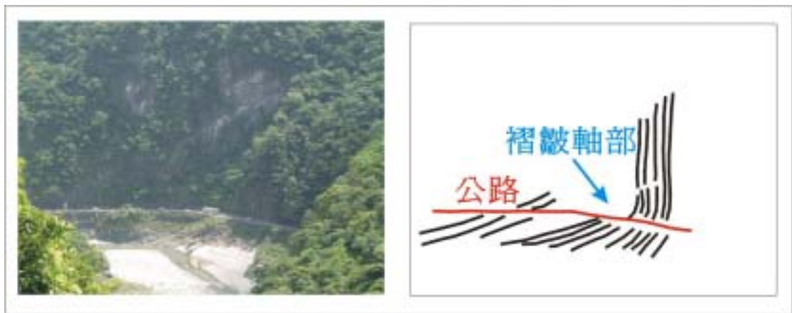
照片一之一、由長春祠這一頭向西拉岸望去，可以見到西拉岸隧道出口處附近出露一個褶皺軸部。
